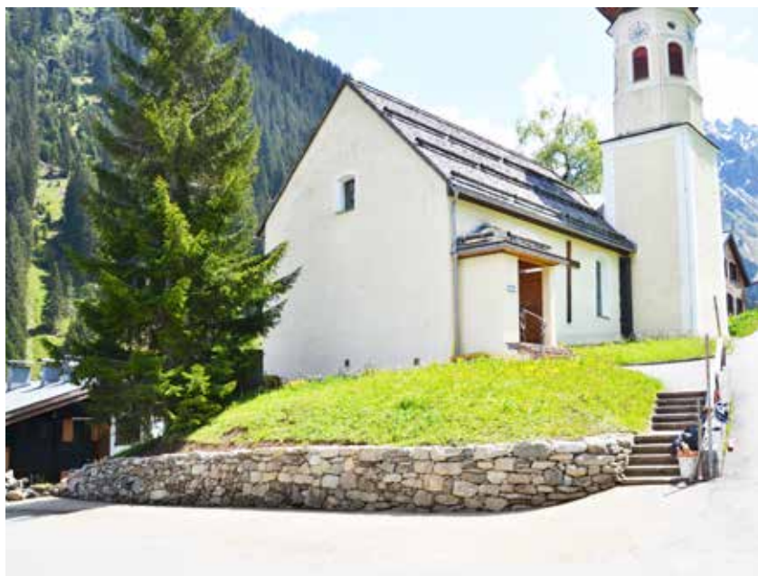
Mauer vor, während und nach der Sanierung. Foto: Friedrich Juen
