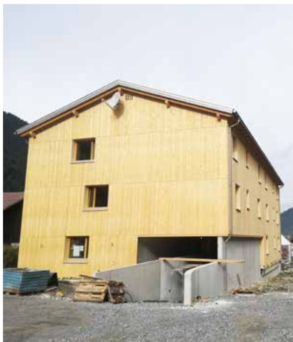
Wohnanlage Gortipohl im Bau
